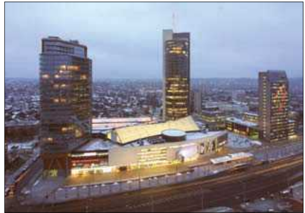
17 pav. Daugiafunkcis kompleksas naujajame Vilniaus centre Fig. 17. Multifunction complex in new centre of Vilnius
