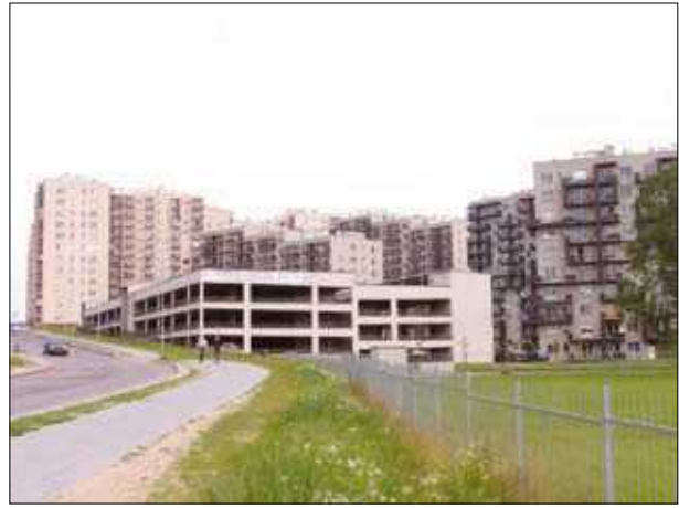
22 pav. Daugiabučių gyvenamųjų namų kvartalas Fabijoniškėse, Ukmergės g. (archit. L. Grikinienė) Fig. 22. Blocks of flats in Fabijoniškės, Ukmergė st. Arch. L. Grikinienė
