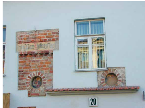
3 pav. Gotikinio mūro fragmentų atidengimas restauruotame pastate
