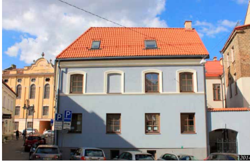
1 pav. Nugriautas ir atstatytas pastatas (Keičiasi Miestai 2015)
