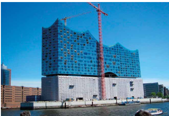
5 pav. Konversija, kai virš išsaugomo istorinio pastato statomas naujas statinys (Elbphilharmonie (Wikipedia 2015))
