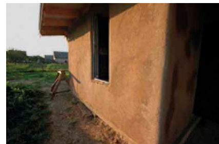
1 pav. Tinkuota karkasinė siena (Manonamas 2012) Fig. 1. Plastered frame wall (Manonamas 2012)
